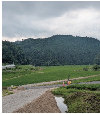
大東町八所地区大型ほ場整備
